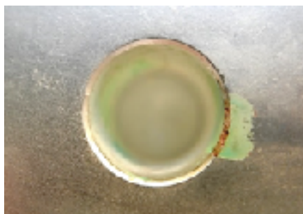
korozní produkty podkladového kovu na hranách
