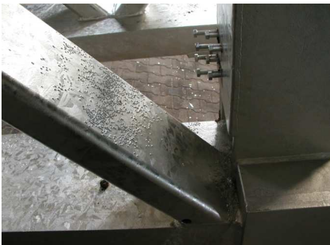
Obr. 5 Naplavené hrudky tvrdého zinku
