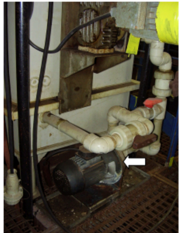
Obr. 4: Dvoupólový dotyk – zkrat se skrytým prvním dotykem přes pohon katodové tyče
