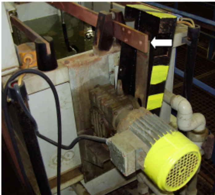
Obr. 4: Dvoupólový dotyk – zkrat se skrytým prvním dotykem přes pohon katodové tyče
